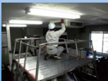
横板を使用して作業スペースを拡張できます。
