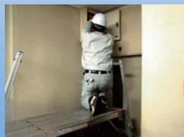
壁側に近づいての作業にも。
