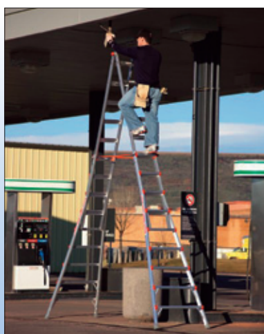
脚立で高所作業を実現。足場いらず。
